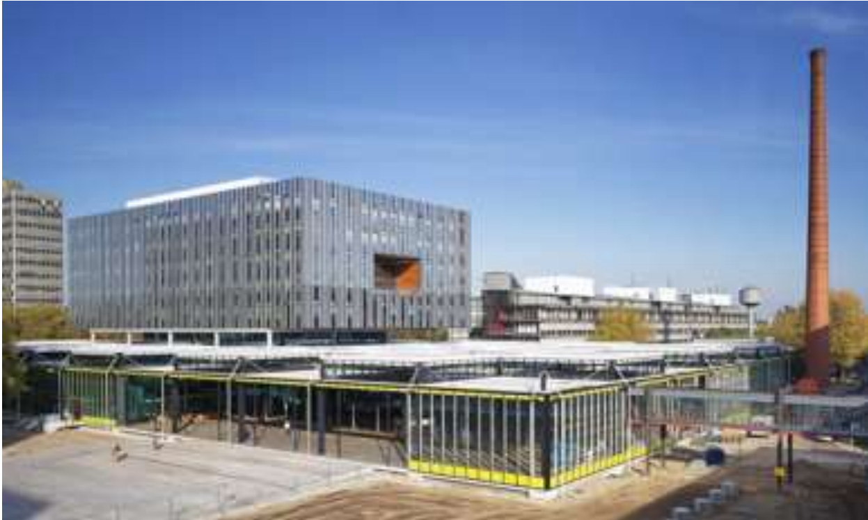
TUE campus 2020 project 1 transformatie W-hal en faculteit Wiskunde
