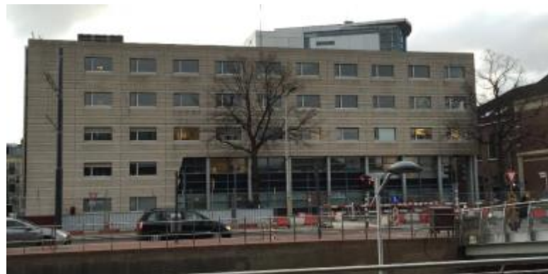
Transformatie kantoor gebouw in Delft Studentenwoningen / 108 studio's
