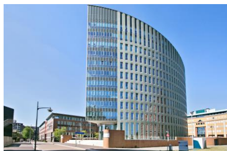
Transformatie Riva in Den Bosch Op basis van de on site energie scan betaald door ING wordt dit pand volledig geupgrade. ING financier de implementatie.
