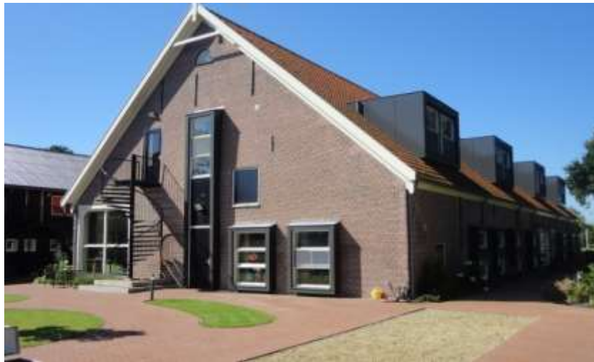
Torenhoeve te Hellevoetsluis
