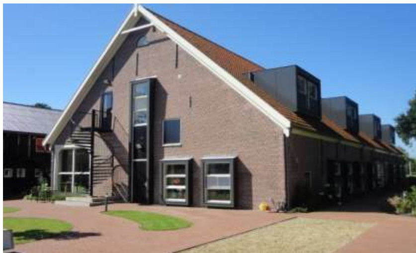
Torenhoeve te Hellevoetsluis
