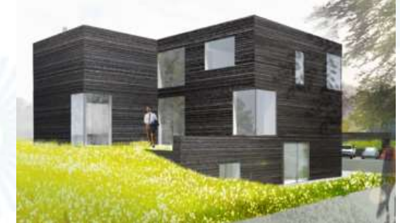
Energieneutrale villa Den Haag
