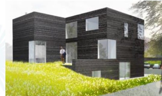
Energieneutrale villa Den Haag
