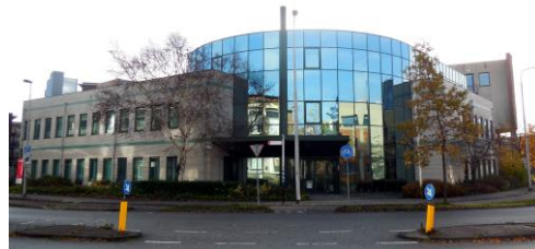
Transformatie oud politiebureau Leeuwarden met 'groenverklaring' naar appartementen
