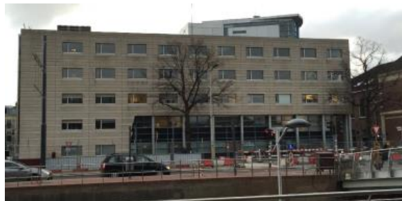
Transformatie kantoor naar studentenwoningen in Delft
