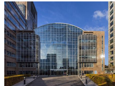
Renovatie Zuidas Amsterdam / Atrium Verduurzaming, er vindt tevens nieuwbouw plaats
