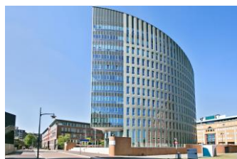
Transformatie Riva in Den Bosch Gebaseerd op energiescan van CFP
