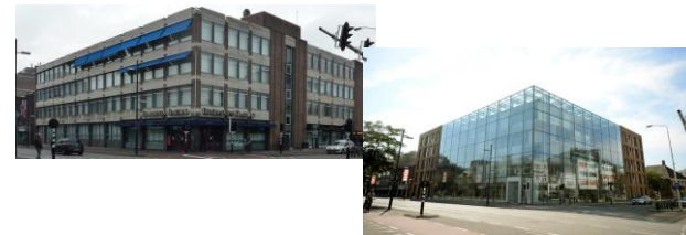
Oude Wal Eindhoven, het oude kantoorgebouw is volledig gesloopt en herbouwd (energielabel A) en fungeert als het nieuwe hoofdkantoor van Woonbedrijf (woningcorporatie).
