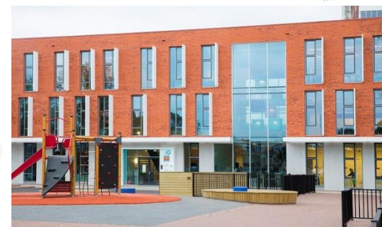
Energieneutrale Plein Oost Haarlem
