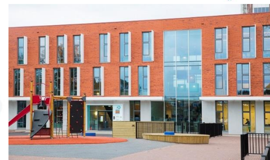
Energieneutrale Plein Oost Haarlem
