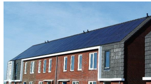
Dak vol zonnepanelen
