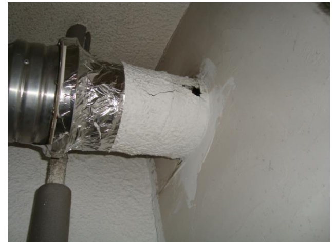
Gaten in de rookgasafvoer in de woning !
