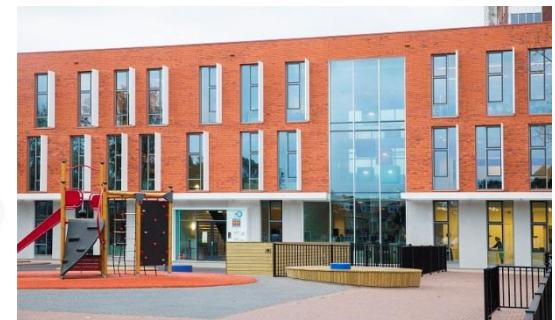
Energieneutrale Plein Oost Haarlem
