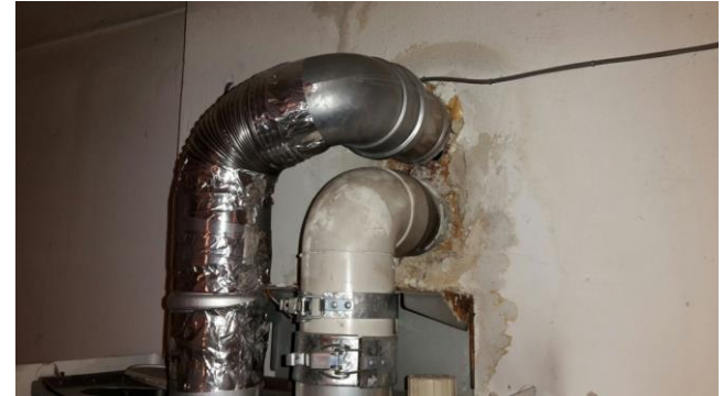
Gaten in de rookgasafvoer in de woning !
