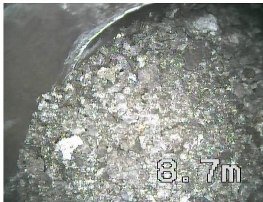
Rookgasbuis Verstopt, condensafvoer los
